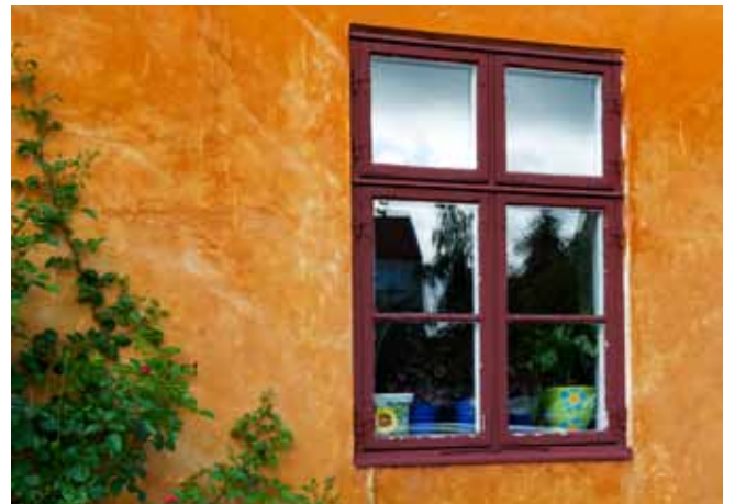
Kalkmjölk pigmenterad med järnvitriol
