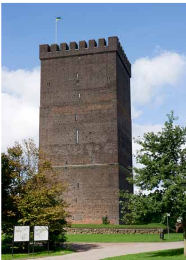
Kärnan i Helsingborg efter omfogning med kalkbruk
