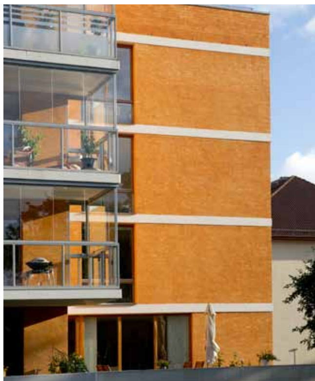
Objektsanpassad puts och kalklasyr
