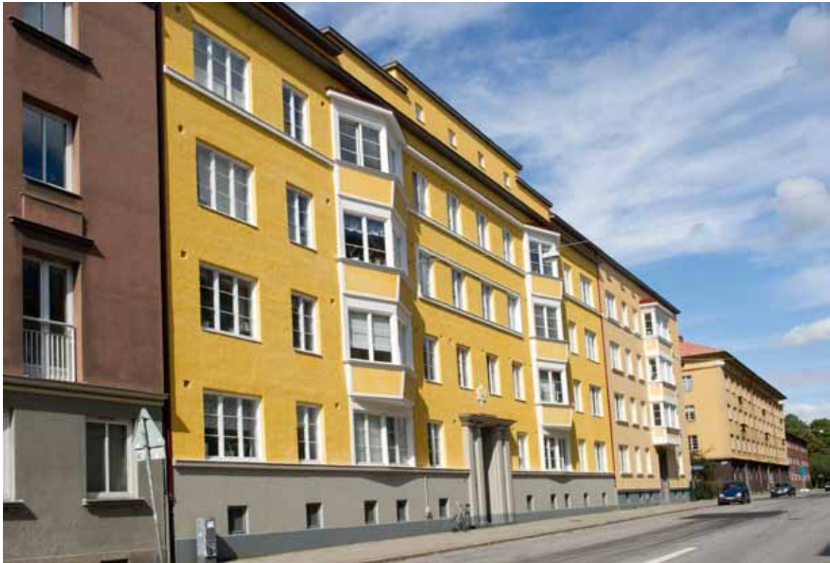
Putsat och kalkmålat med Kulekalk
