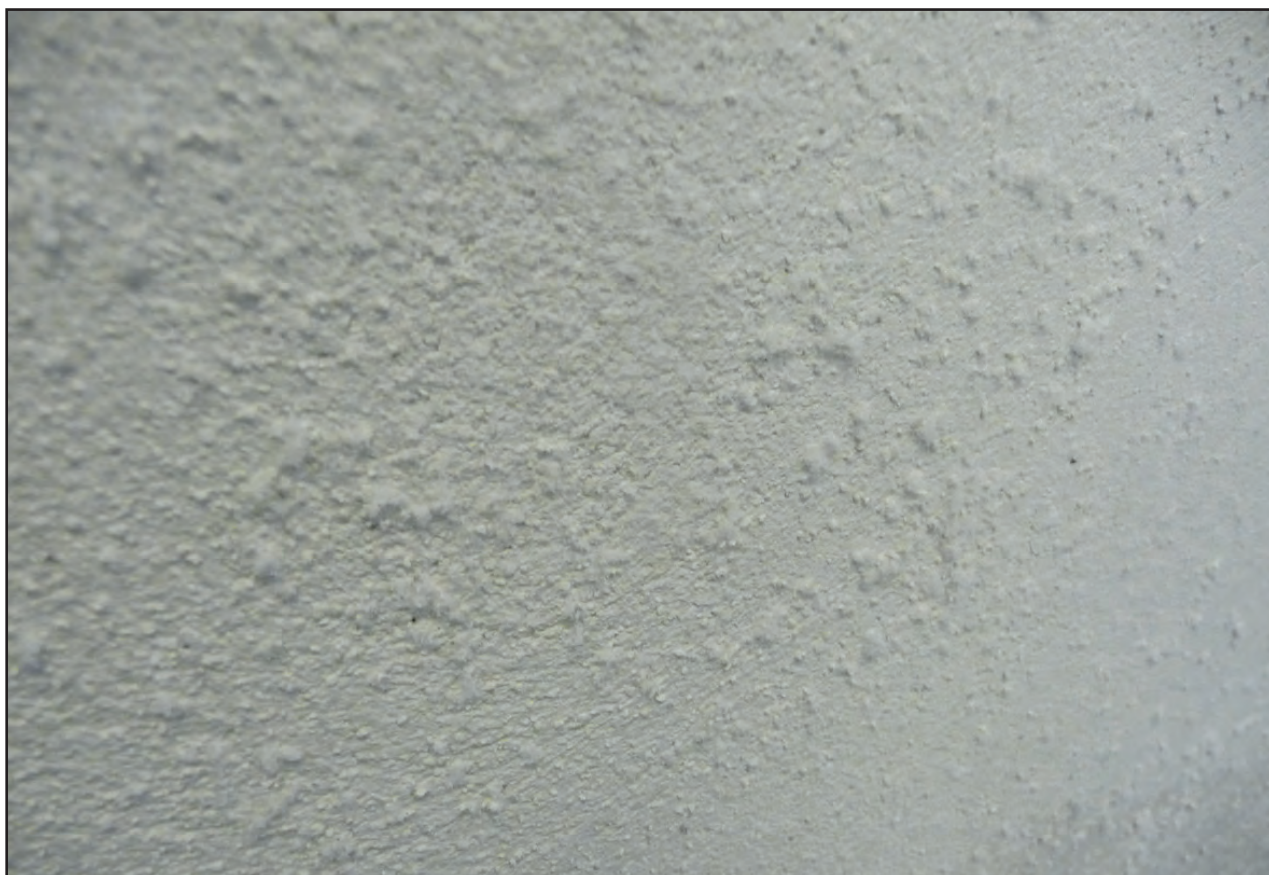
Saltkristaller på Thermosilit offerputsad yta, Sveriges Ambassad i Prag
