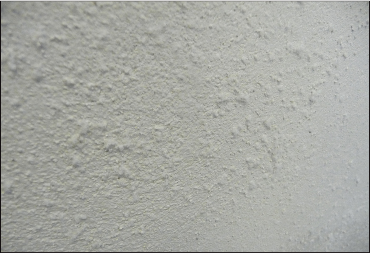
Saltkristaller på Thermosilit offerputsad yta, Sveriges Ambassad i Prag
